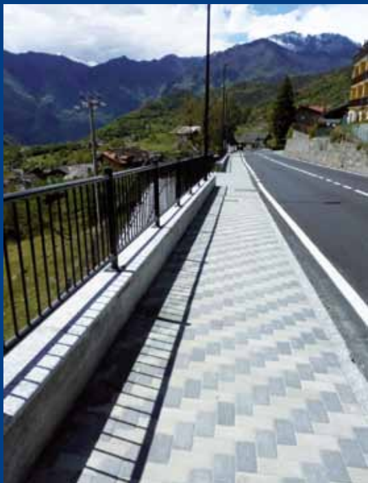
Completamento del marciapiede con il nuovo impianto di illuminazione lungo la strada regionale 45 della frazione Châtagnère.
